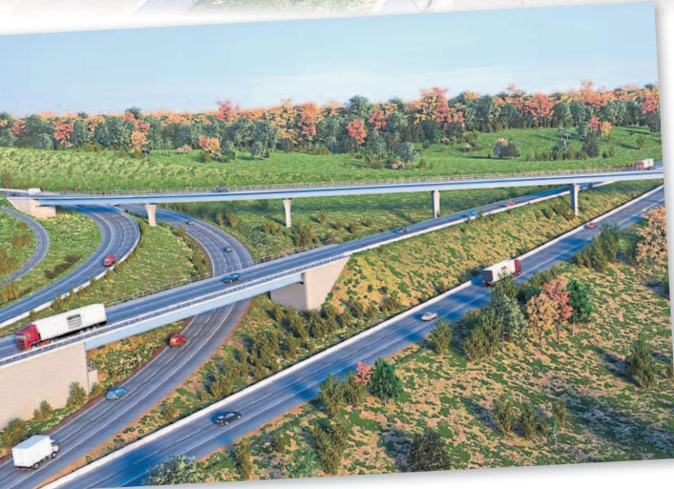
Blick aus Richtung Gemünden auf das Autobahndreieck Ohmtal. Vorne die Fahrbahn der A 5 in Richtung Alsfeld/Kassel. Die dahinter verlaufende Fahrspur in Richtung Frankfurt führt über einen Damm und eine Brücke, damit Fahrzeuge in Richtung Stadtallendorf auf die A 49 wechseln können.
