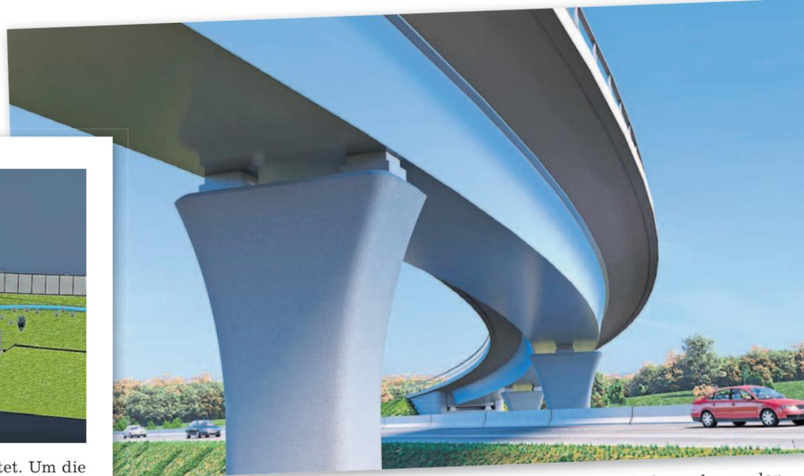
Eine wuchtige Brücke ist für die Verbindung der geplanten A 49 an die A 5 am Ohmtal-Dreieck nötig. Dabei wird die Fahrspur aus Richtung Stadtallendorf/Homberg nach Alsfeld/Kassel in einem weiten Bogen über die A 5 geführt. Mächtige Pfeiler stützen die Fahrspur.
